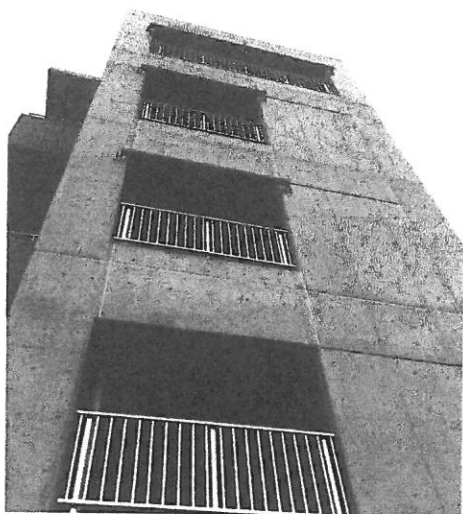
ホース乾燥塔兼訓練塔・側面
