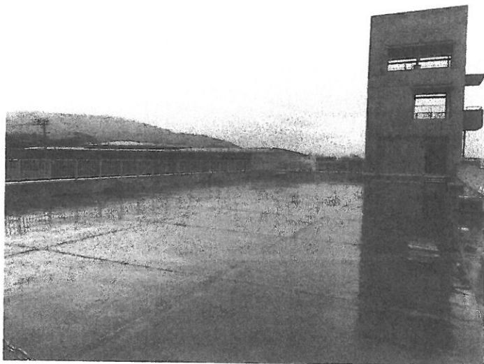
訓練スペース（車庫屋上）
